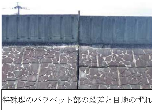
図-2.14(2) 擁壁の被災事例（白川右岸 8k600～8k900）
