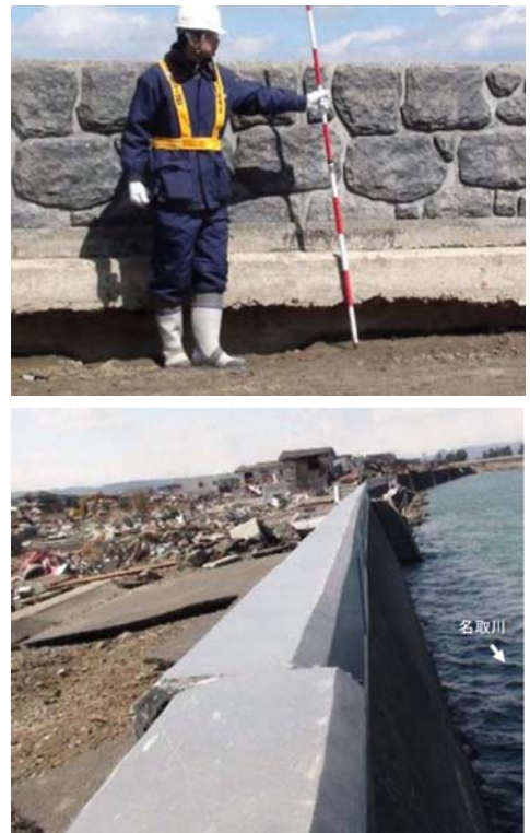
図-2.13(2) 擁壁の被災事例（名取川名取市閑上地先）
