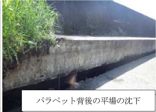
図-2.14(1) 擁壁の被災事例（白川右岸河口付近）
