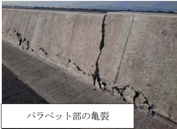
図-2.14(1) 擁壁の被災事例（白川右岸河口付近）
