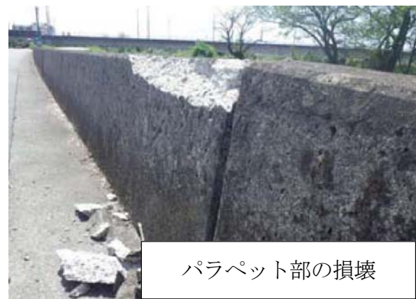
図-2.14(3) 擁壁の被災事例（白川左岸 8k400～8k800）
