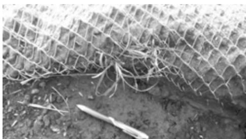
写真-1 ToCR の中詰材に定着するハチジョウススキの様子
