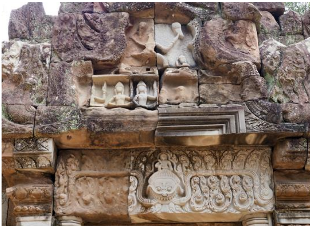
写真6 チャウ・サイ・テボダにおける新材への彫刻（上部ペディメントの新材では人物の輪郭彫刻にとどめる一方、下部リントルのモチーフには細部彫刻を施している）
