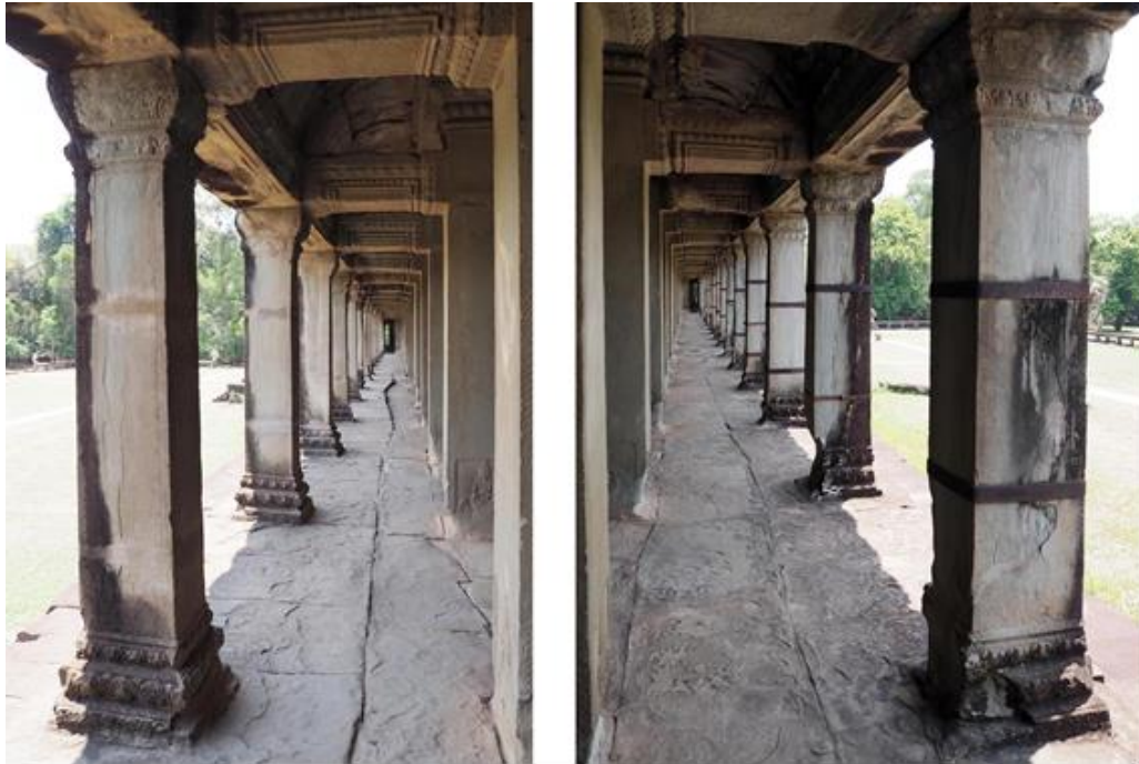
写真5 アンコール・ワット外回廊の列柱（左：削り込んだ石材の溝内に鉄バンドを埋め込んだ補強，右：鉄バンドを柱の上に直接巻き付けた補強）
