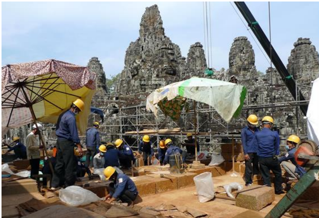
写真 2 バイヨン南経蔵の修復工事 (日本国政府アンコール遺跡救済チーム)
