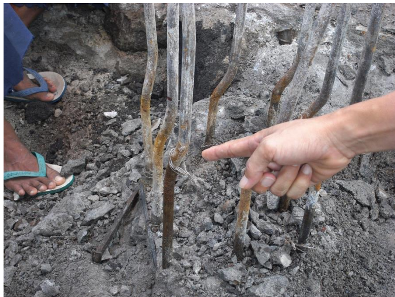
図10 ナンディ祠堂頂部の半解体修理 鉄筋が曲がっている
