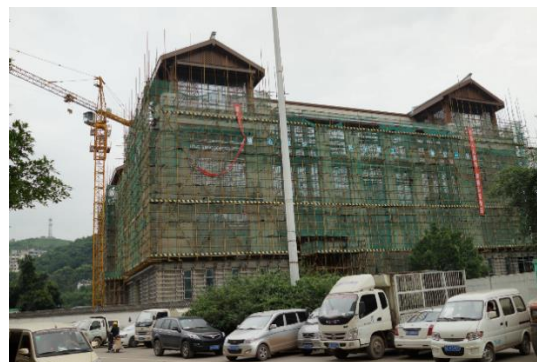
写真 4-3 建設中の茅台五つ星ホテル(会社建設) 注4-29)
