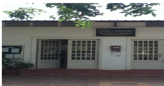
写真Ⅱ- 27 RUA 農業機械学科棟
