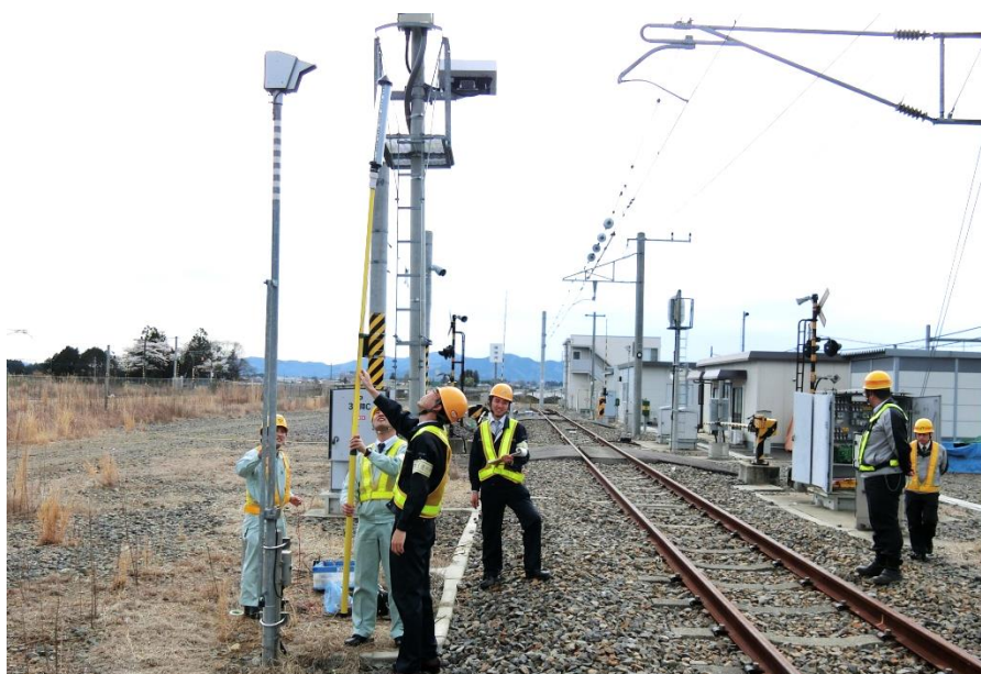
図 73 保守用車踏切制御装置への影響評価試験風景
