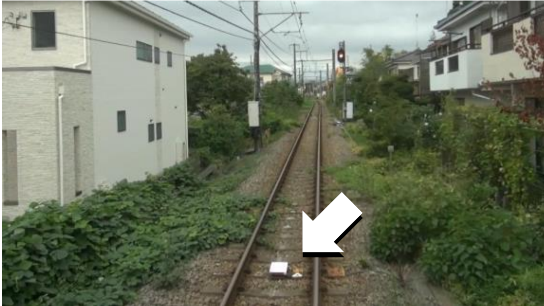
図 85 位置補正として登録した地上子
