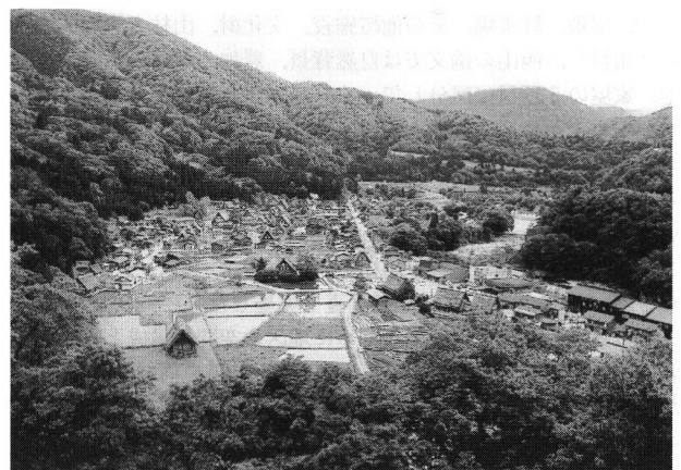
写真-1 地区の全景
