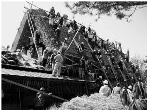
写真-1 「結い」による葺き替え
