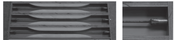
図 3 型枠および鉄筋接合状況
