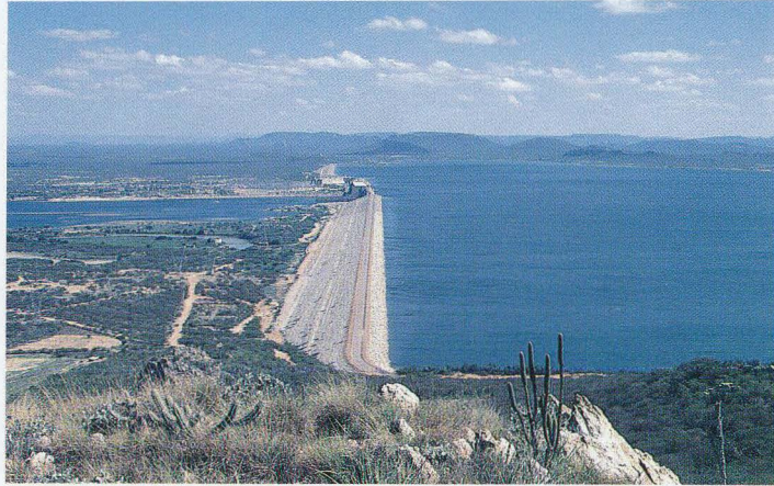
写真1 ソブラディーニョダム（1989年12月） ダムの下には発電所があり、水は灌漑、発電、水量調整などの多目的に使われる。
