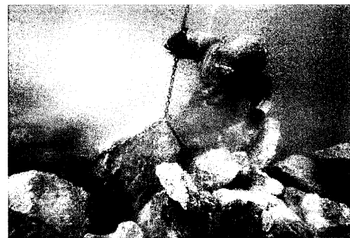
図1 潜水士による捨石マウンド均し作業
