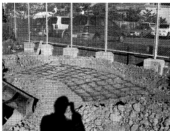
図 15. 作業後のマウンド形状 (無視覚遠隔操作)
