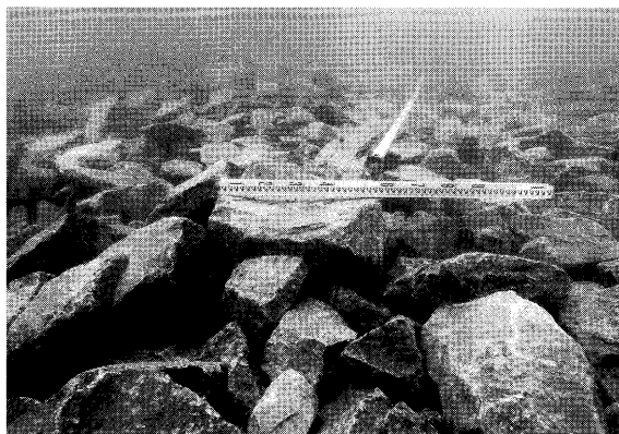
図 19. 作業後の捨石マウンド状況
