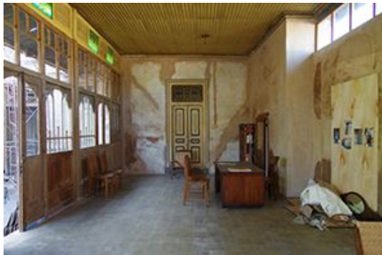
図2 コタゲデの近代家屋の修理（開口部は取り替え、煉瓦組積壁はコンクリートの柱を挿入し耐力を上げている）
