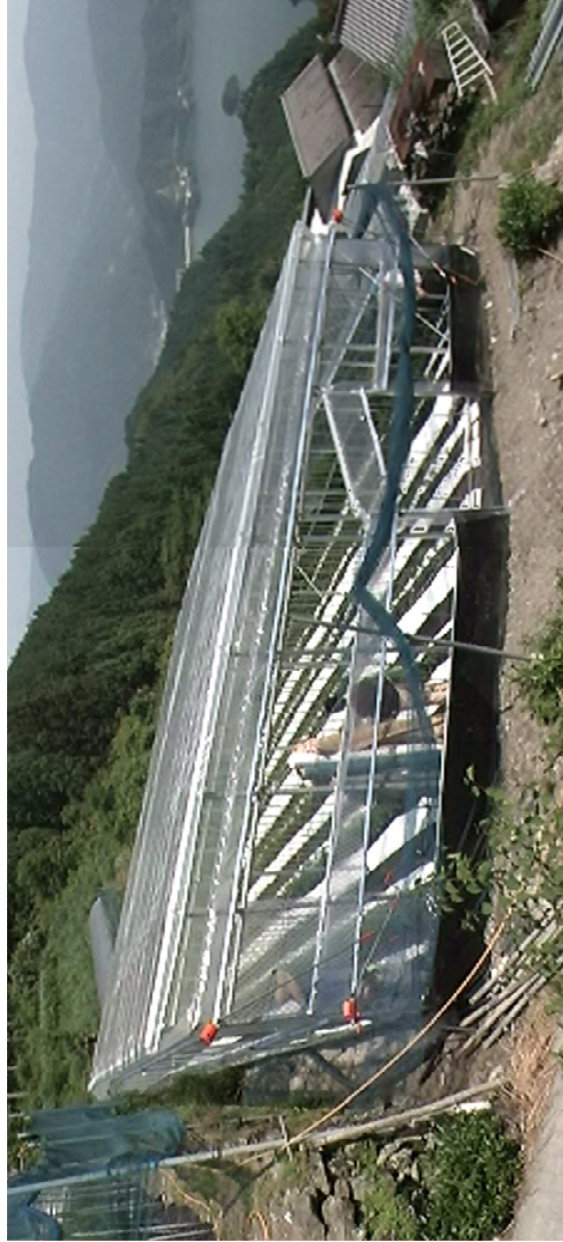
図3-6 開発した平張型傾斜ハウスの実施工例
