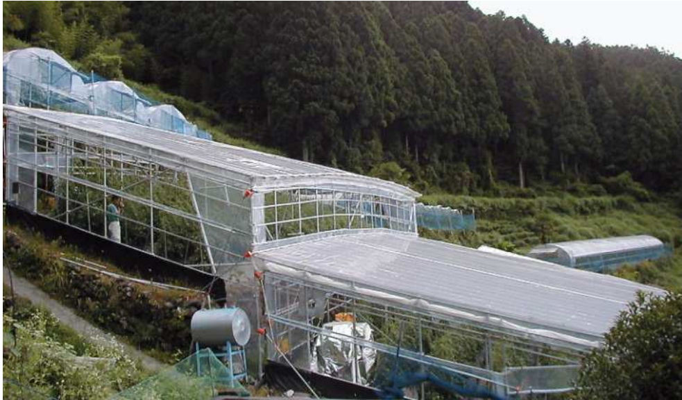
(1)傾斜段畑に設置された平張型傾斜ハウス
