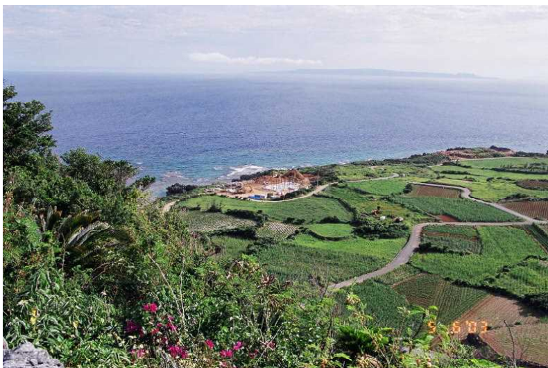
写真1 建設中の火葬場
