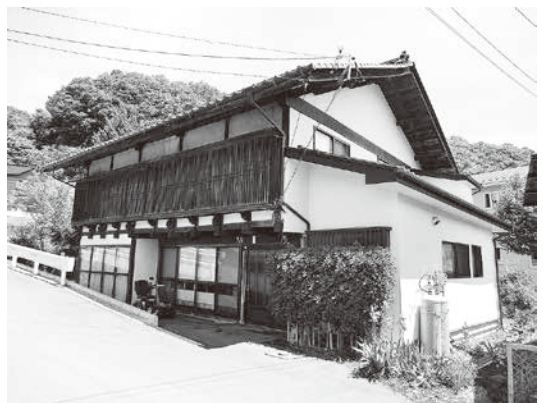
写真2 出桁造の軒の一例
