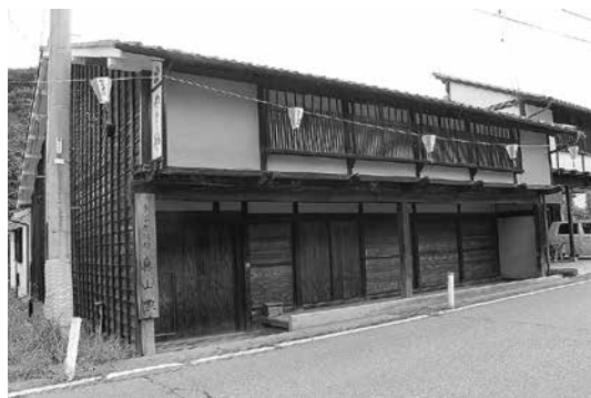
写真7 真山家・大和屋の外観(2014年) (2014年8月 渡辺撮影)
