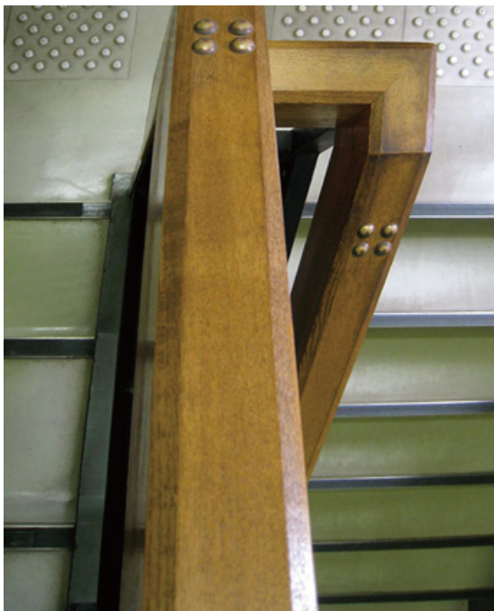
図 2-30 階段手すり金具による階数表示
