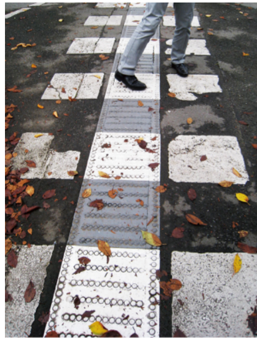
図 2-32 構内の横断歩道に設置された点字ブロック (筆者撮影) 日本 筑波技術大学保健科学部 (視覚障害専門) 撮影日) 2010年10月4日
