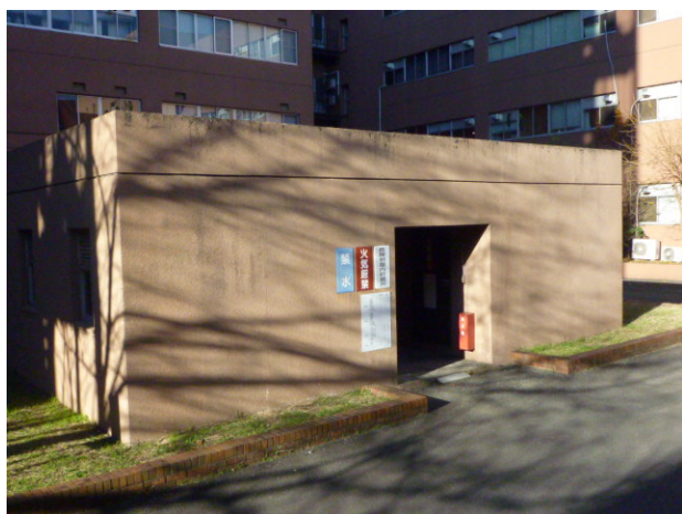
図 4. 数理物質エリア・工学系危険物貯蔵所
