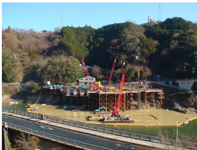
写真－5.2.4 湖内工事の行われている鹿野川ダム貯水池（2012年12月）
