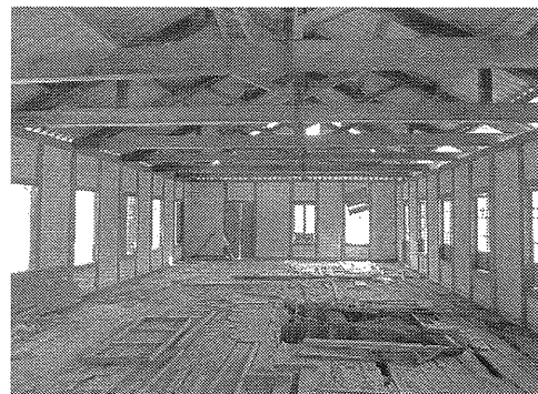
写真 8：キングポストを用いた製茶工場の大空間
