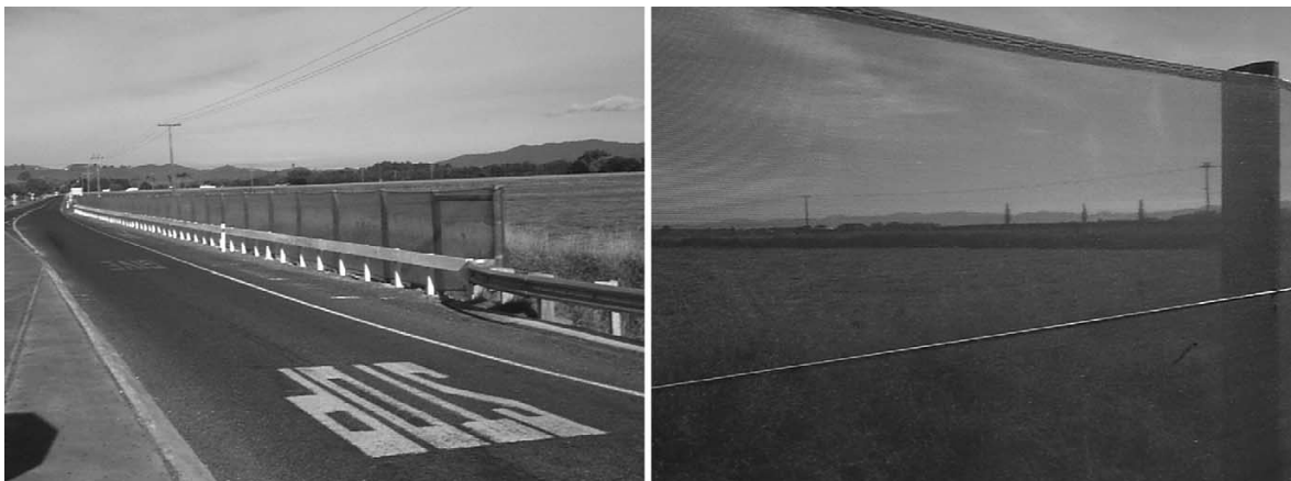
図 2.2 郊外交差点への視界障害物 (スクリーンシェード) の設置状況 (出典: Charlton, 2003)
