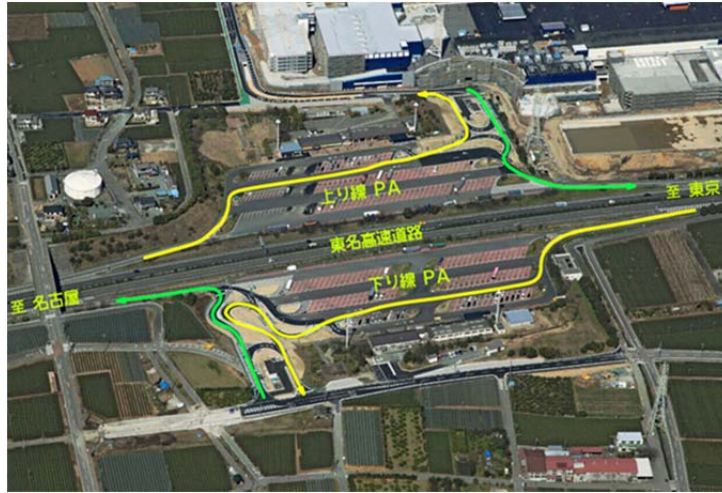
図 3.5.5 遠州豊田スマート IC の全景
