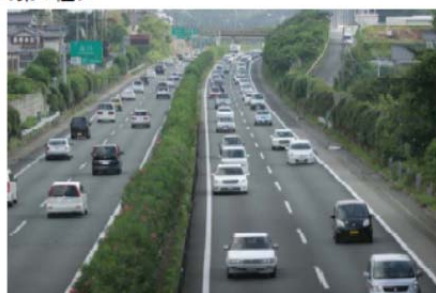
九州自動車道(福岡県)
