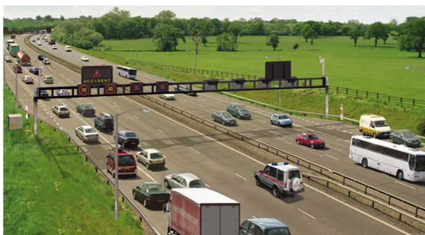
図 2.10.6 事故処理のための一般車線閉鎖と路肩走行
