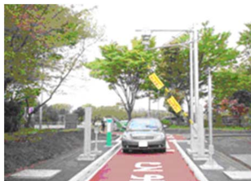
図 3.1.1 三芳パーキングエリアに設置されたスマートIC 国土交通省道路局 HP より引用
