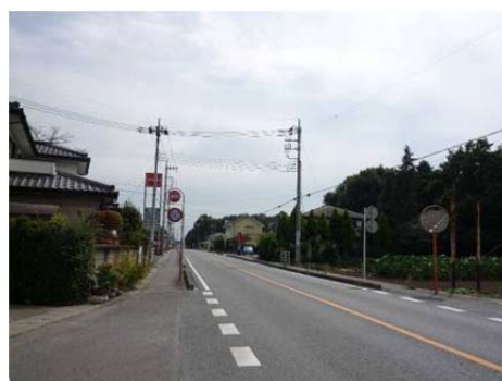
図 3-3 中④番の街路の状況 地区内補助幹線道路
