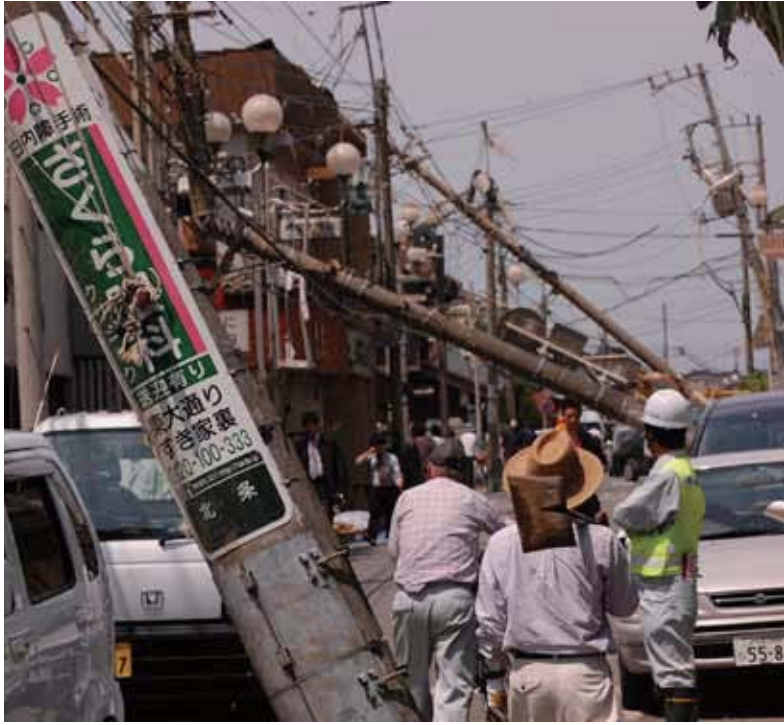
竜巻で電柱が倒れるなど、大きな被害を受けた北条地区
