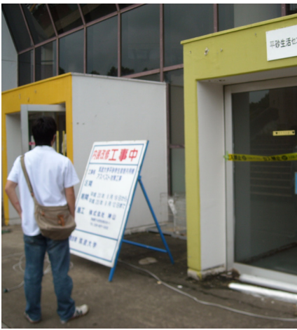
アスベスト工事中の平砂共用棟
