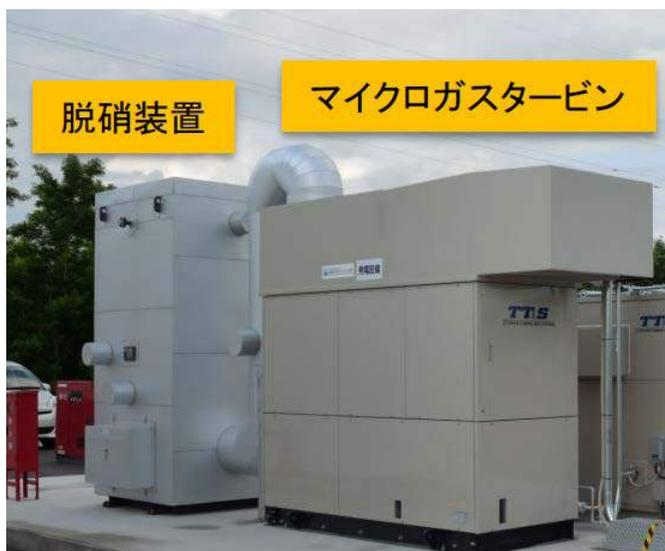
**灯油燃料の30%相当をアンモニアに置換して混焼を行い、21kWのガスタービン発電に成功 (世界初)**
