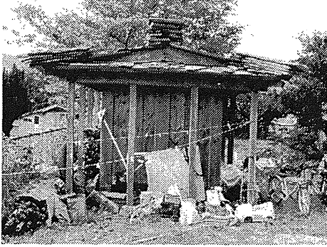
写真 2.6.-6 十数年前に豆殻石のみで葺かれた石屋根（2005年8月17日撮影）
