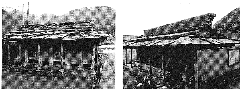
写真 2.6-15 左：イタイシの石屋根 右：島山石の石屋根
