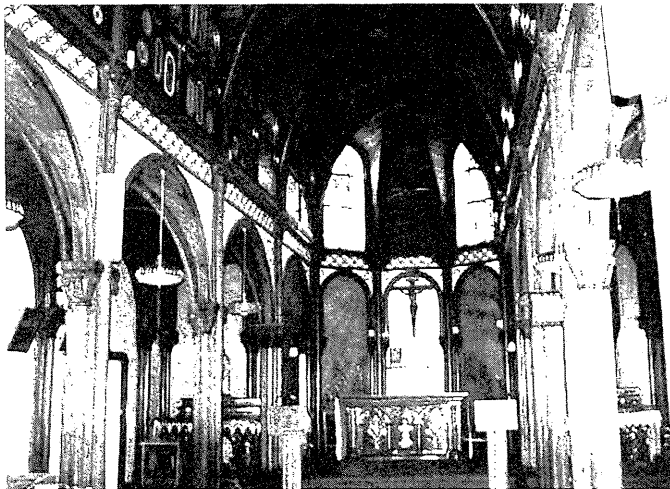
写真16 リブ・ヴォールト式の天井（2004年7月撮影） コウモリが羽を広げたような形から、コウモリ天井とも呼ばれる。煉瓦造の教会堂に多くみられる。写真は山田教会（平戸市生月地区）。外壁は煉瓦造であるが内部は木造である。
