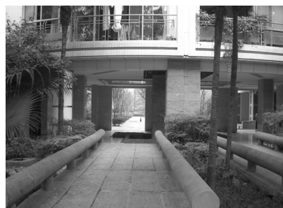
住棟の1階はピロティになった (通り抜けが可能である)
