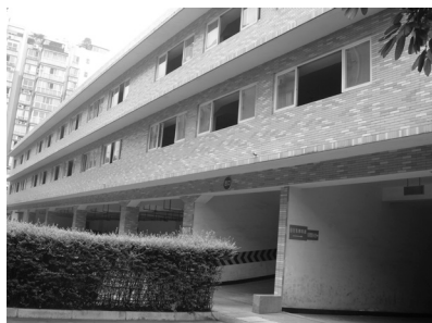
立体駐車場になっている
