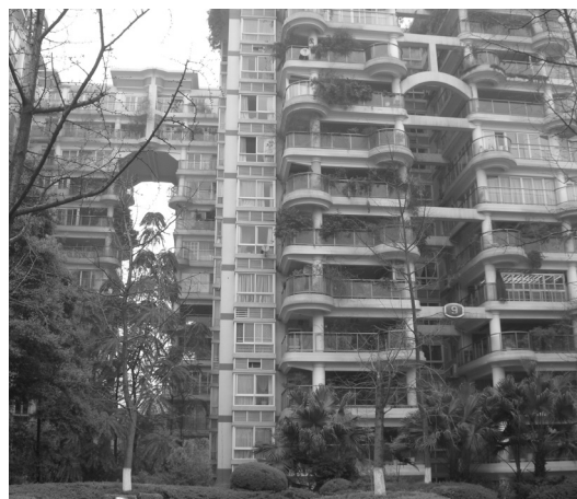
団地は富裕層向けのため、多様な住棟形式が見られ、広いバルコニーが特徴である。
