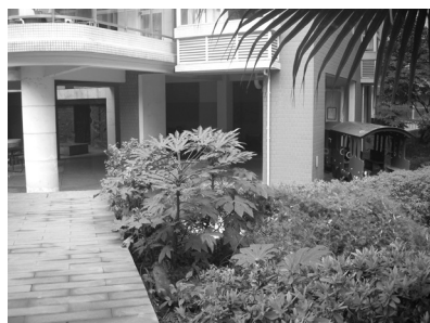
住棟の1階はピロティになった (運動施設、休憩施設の配置)
