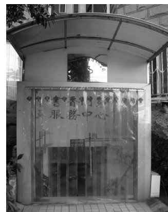
管理会社用の管理室 (計画されていないが、地下空間を利用して増築した)
