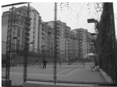
会所の屋上空間はテニスコートとして使われている
