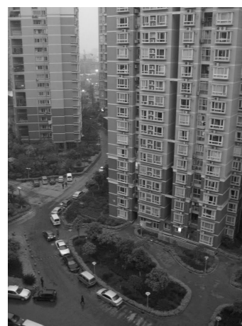
高層住棟周辺の緑地
