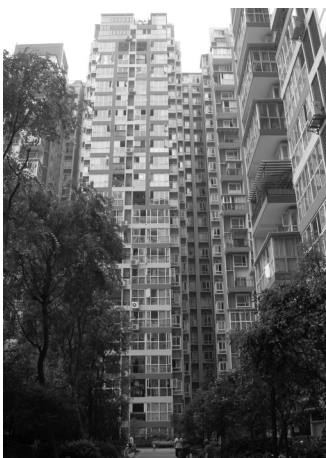
超高層住棟の様子
