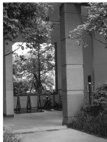
1階がピロティになっており、駐輪場と運動器具が設置されている
