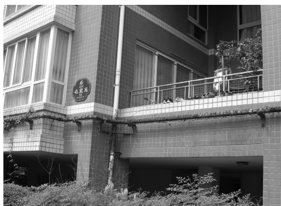
団地Aにおける住棟外壁に防犯網を設置した事例
