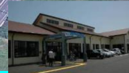
ペットボトルのリサイクル施設
