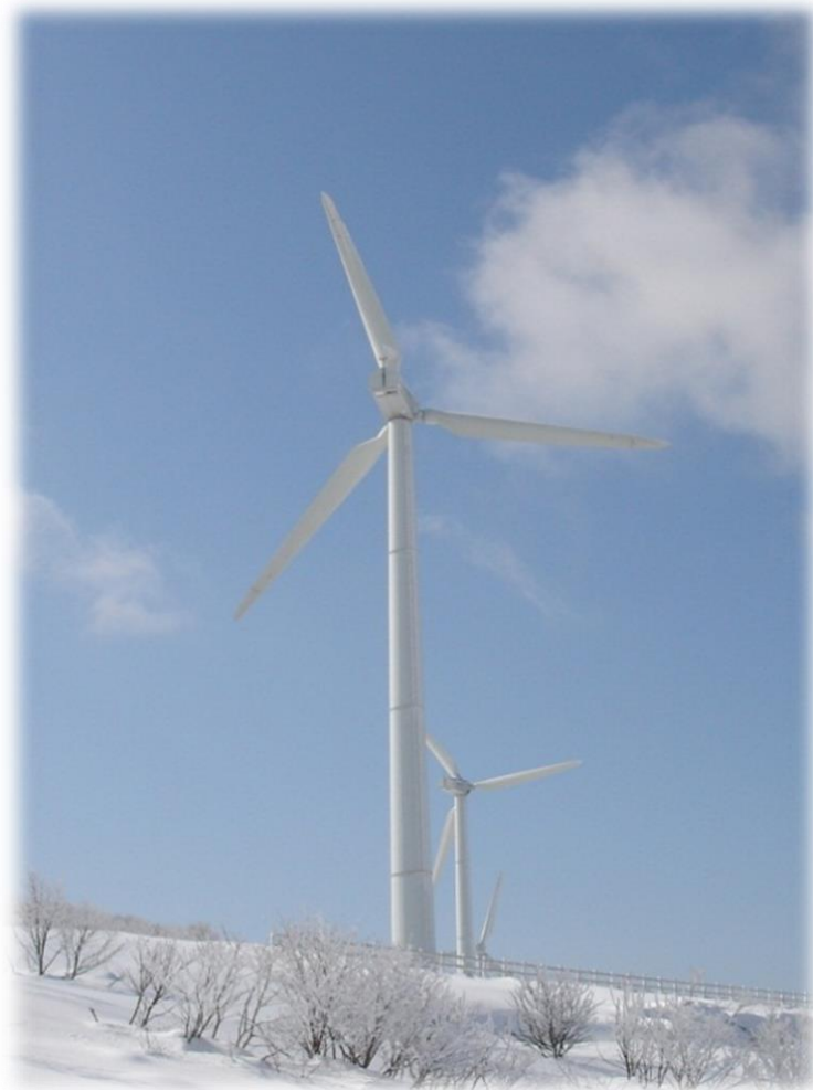
エコ・ワールドくずまき 風力発電所
