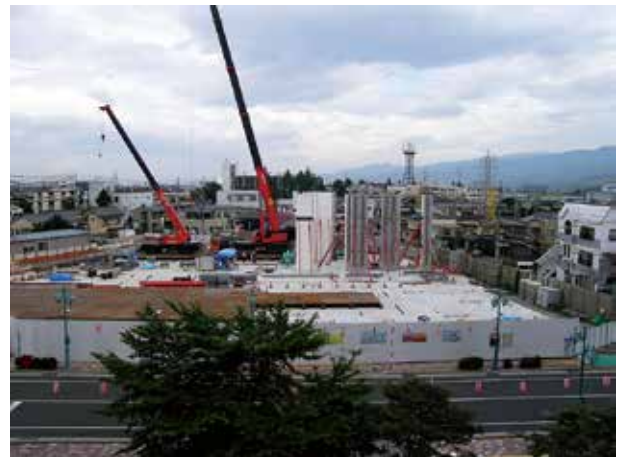
塩尻市市民交流センターの建設風景 97本の壁柱が特徴的、地下1階・地上5階建てのビル。市立図書館を核に、子育て支援センターや市民会議室、オフィス、カフェが入る。 設計・コンテンポラリーズ
