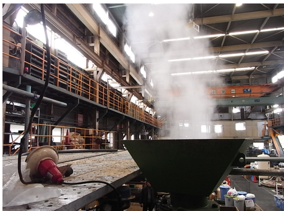
写真9 バルブを開放しての蒸気排出中
