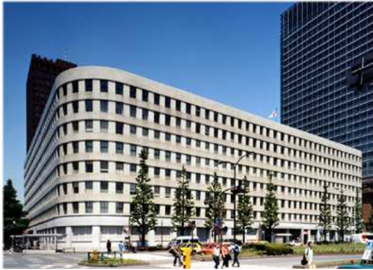
図 4-4 建替え前の新丸ビル 5
