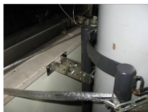
図 15. 高圧ガスポンペ立ての固定例
