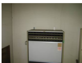
図 22. 専用ボルト・金具にてボード壁と固定
