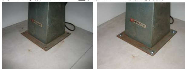
図 26. 移動したグラインダー(左)とボルト止め後(右)
