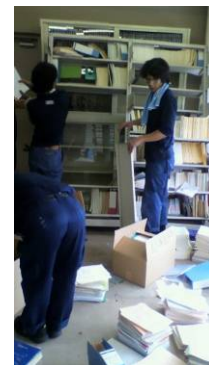
図 9. 2A 棟 5 階教育学系図書室転倒した書架と改善例
