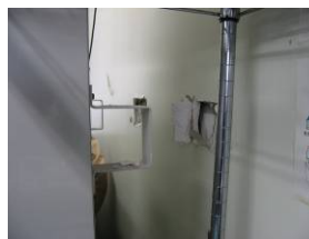
図 16. 固定が外れた冷蔵庫
