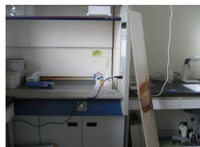
図 11. 6 階実験室 ドラフトダンパー落下
