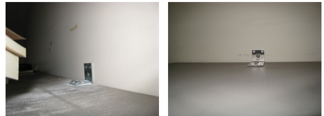
(E) ボード用アンカーを数か所設置した例
