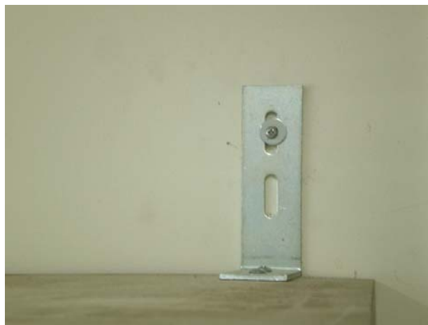
図12. 震災前から戸棚の上部をL字金具で壁に固定(震災後に撮影)
