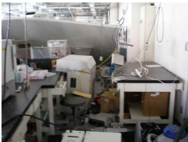
図6. 間仕切りの倒壊と実験台からの装置の転落
