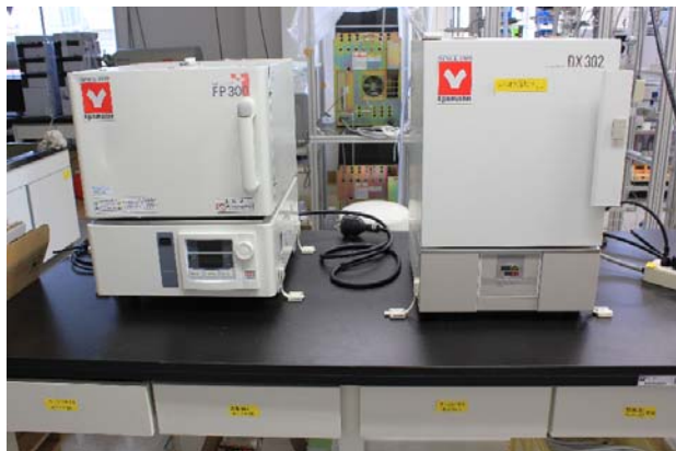
図9. マッフル炉と恒温乾燥器の固定 装置と実験台の間に耐震用ゲルを挟み、バンドで実験台に固定
