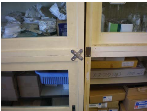
図 13. 震災前から上段と下段の戸棚を金具で固定 (震災後に撮影)
