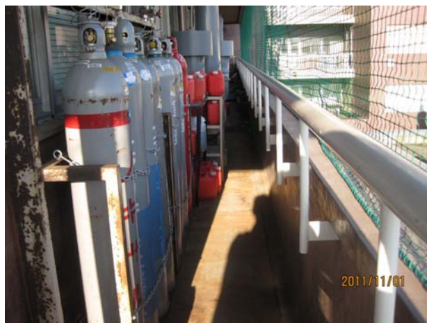
図4. 復旧後の高圧ガスボンベ置き場
