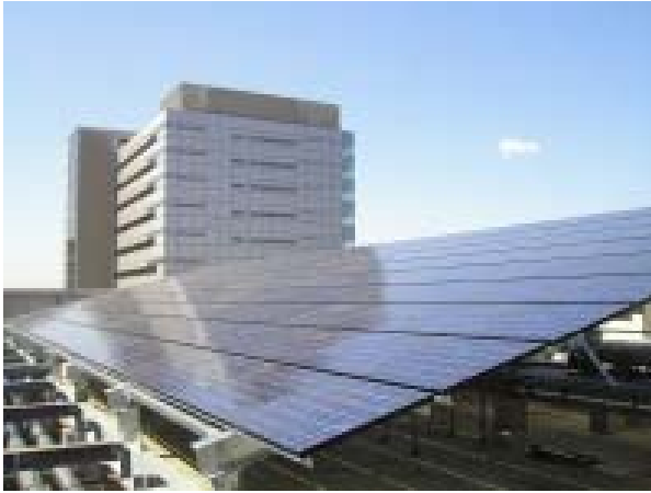
産総研の1MWシステム 写真は多結晶シリコン
