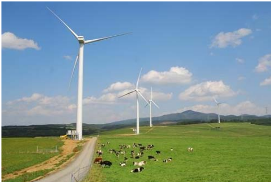
大規模風力発電システム、青森県二又 (51MW=1.5MW x 34, NaS battery: 34MW)
