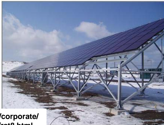
北海道稚内の大規模太陽光発電システム (PV: 5MW, NaS battery: 1.5MW, capacitor: 1.5MW)
