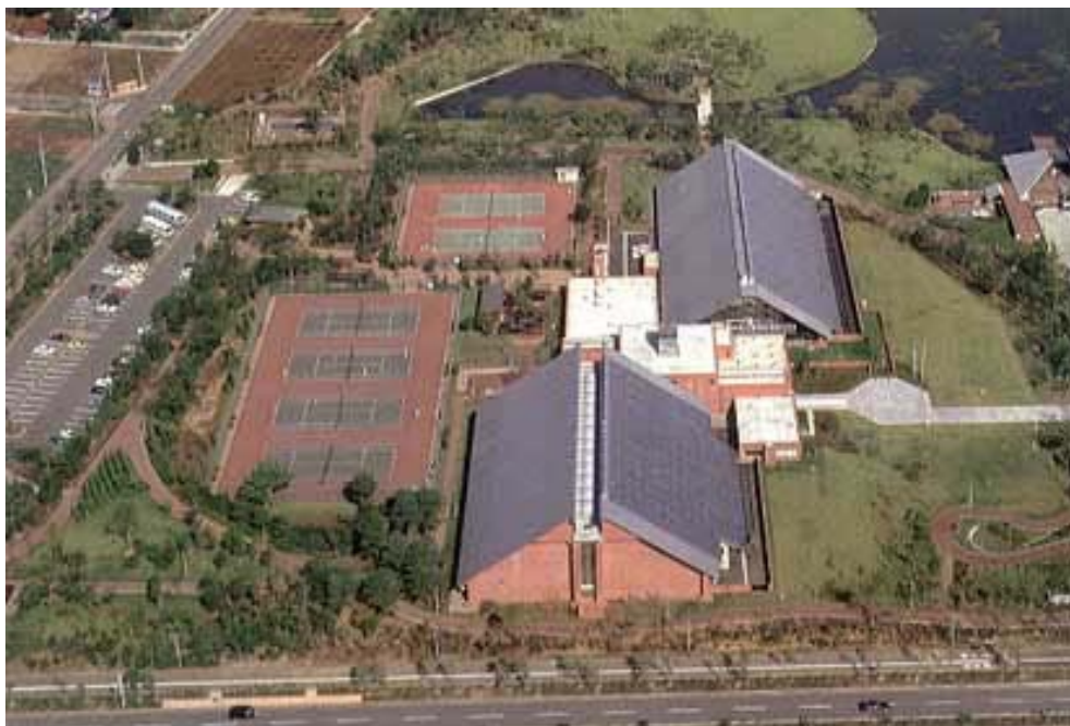
洞峰公園 国内最大級の太陽熱利用施設 集熱面積: 1912m 2 , (1980年7月導入)
