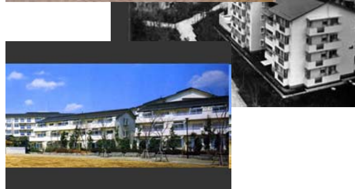
さくら団地 太陽熱利用ヒートポンプによる集合住宅 24戸の個別給湯システム(1985年)
