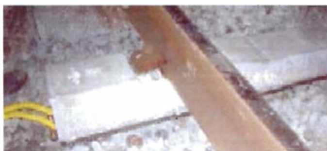
図 2.5 センシングまくらぎ敷設状況 15)
