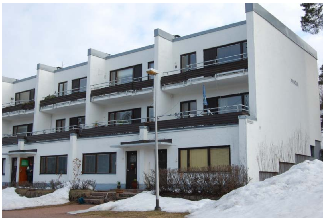
図4 スニラの工場エリアのアパート（2010年4月著者撮影）竣工1938年
