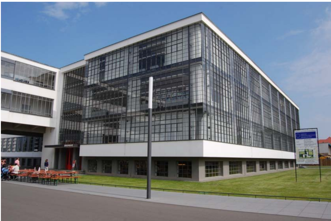
図2 バウハウス・デッサウ校舎 ガラスのカーテンウォール (2010年5月 著者撮影)
