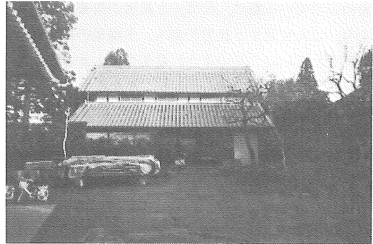
写真6 2階建ての作業舎 (1984年11月)
