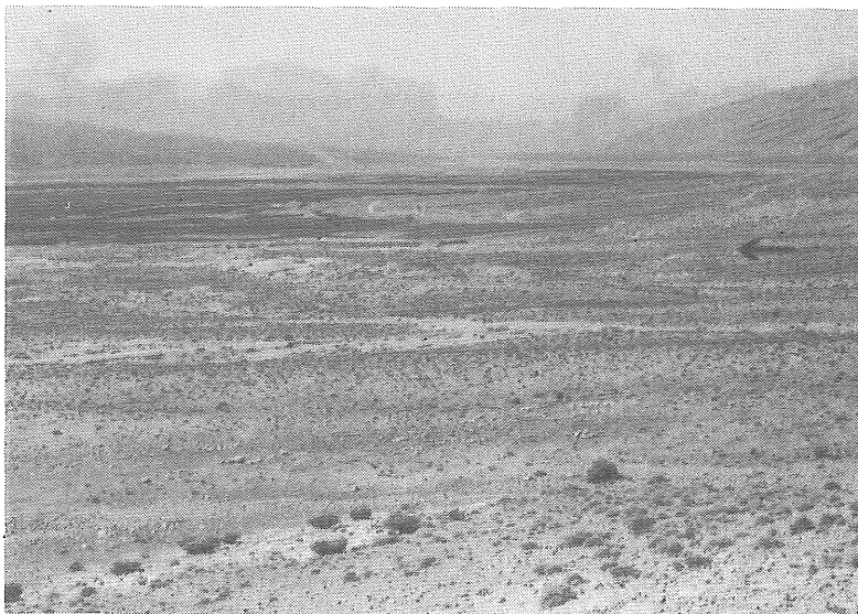
写真－1a カナート。矢印の方向に並んでいるのは竖穴，前方に灌漑地がみえる。
