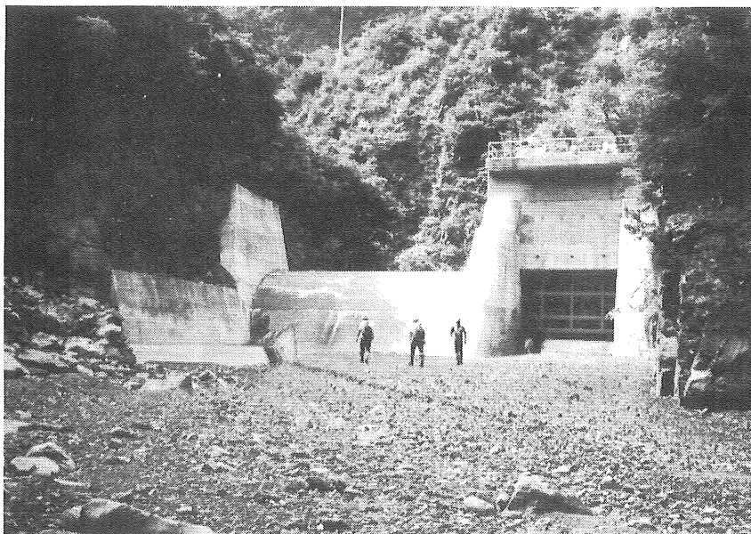
写真2. 1979年8月9日撮影 取水堰堤直下の様子
