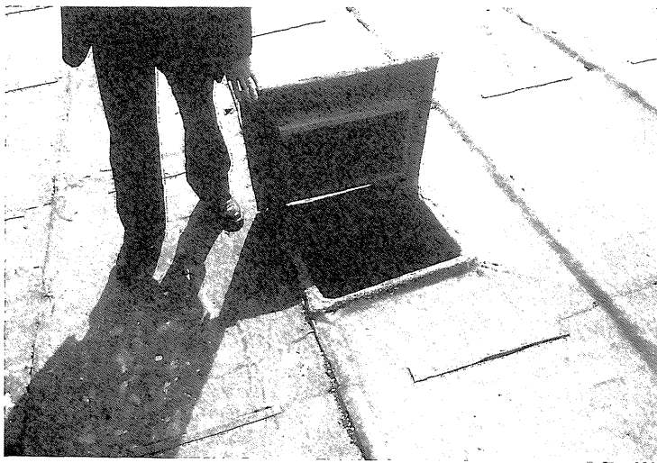
[ Fig. 12 ] ドーム・ベースの屋根。小窓を通して古い屋根を見ることができる。
