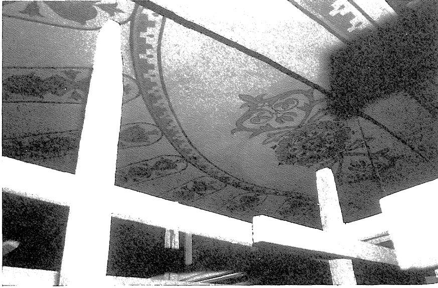
[ Fig. 10 ] 西側半ドームの頂部
