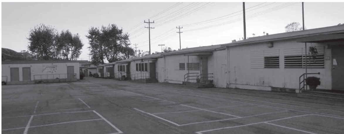
バデューゴウッドランズ小学校の仮設教室 (筆者撮影)
