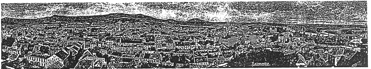
図-I-2 エルベ河畔のライトメリッツ市全景
