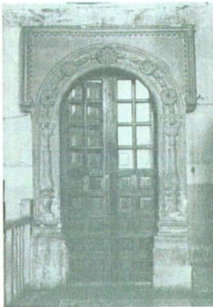
Fig.111 パツクアロ、フランシスコ会 修道院病院礼拝堂香部屋入口
