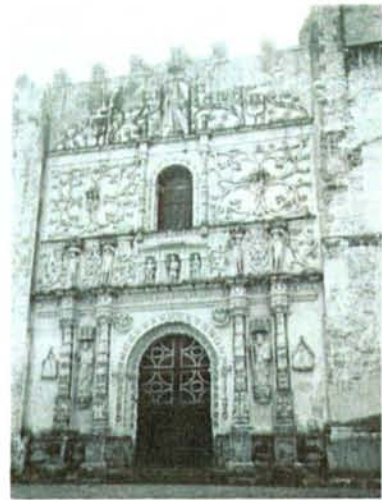
Fig.81 ユリリアブンダロ、 アグスティン会修道院教会堂正面
