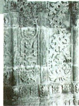
Fig.77 オトゥンバ、フランシスコ会 修道院入口アーチ部分
