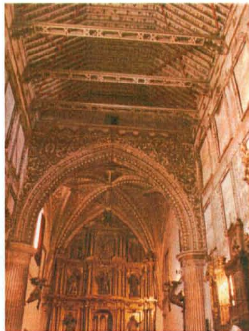
Fig.15 ムデハル様式、カルモナ、 サンタ・クララ修道院教会堂 (木製天井)
