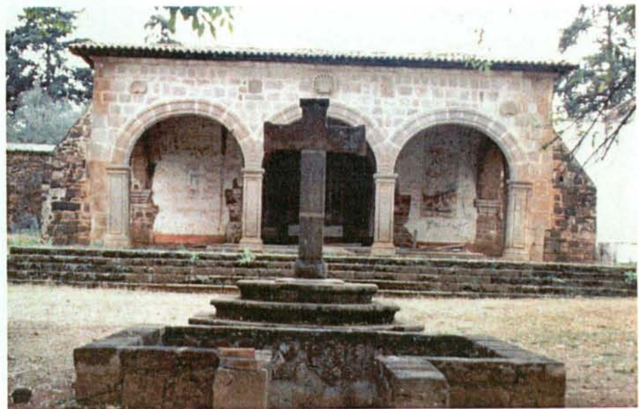
Fig.108 ツィンツンツァン、フランシスコ会修道院病院屋外礼拝堂
