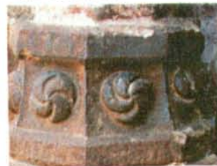
Fig.92 アンガウアン教会堂旧屋外礼拝堂開口部柱基部
