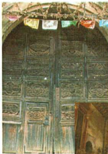
Fig.72 教会堂入口扉 (ヌリオ教会堂)
