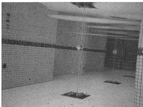
図2-3 吸い付け事故のリスクを抱えたまま運営されている水泳（バーディー）プール
